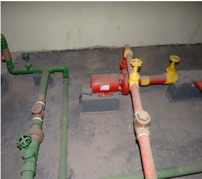
Errado: registro de recalque, na calçada, sem engate rápido, sem engate rápido e sem drenagem de fundo
