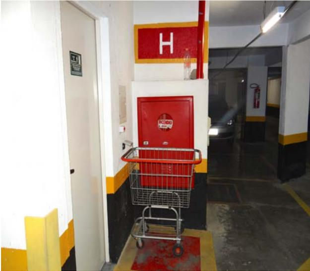
Errado: falta da demarcação no piso das garagens sob o extintor. A demarcação tem o objetivo de sinalizar que nada pode ficar depositado naquele local.
