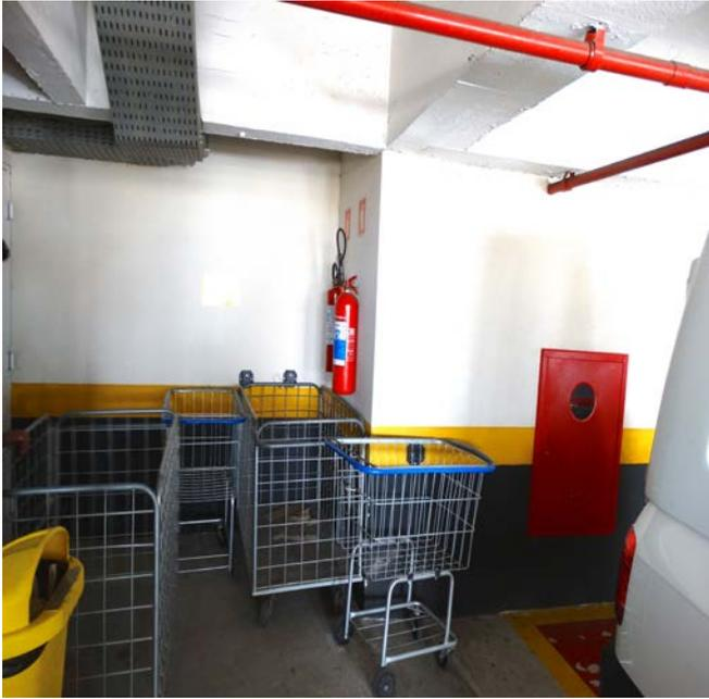
Errado: extintor posicionado em local diferente do constante no projeto técnico de combate a incêndio e dentro de espaço de vaga de estacionamento
