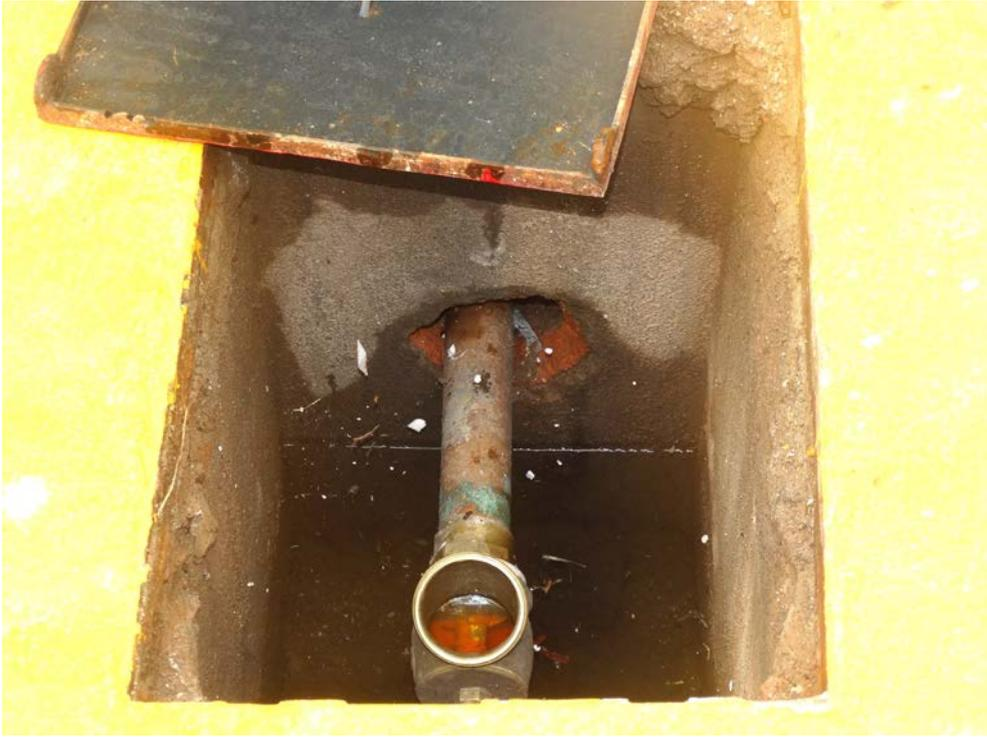
**Certo: registro do recalque com engate rápido e tampa de proteção**
